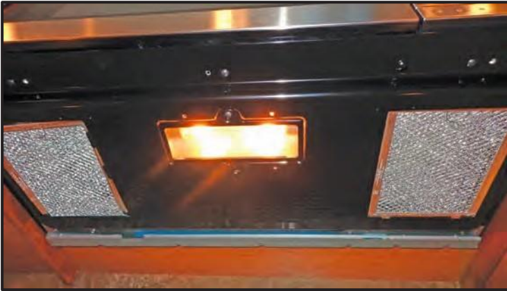
Figure 6-4: Air Filtration Fan
