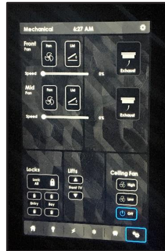
Figure 15-5: Vent Fan Switch
