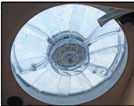
Figure 15-4: Overhead Vent Fan
