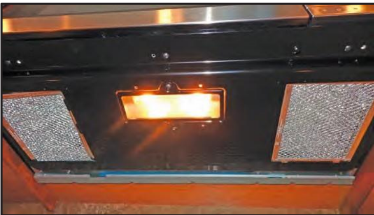
Figure 5-4: Air Filtration Fan
