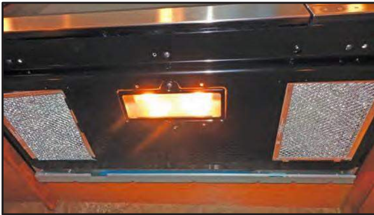
Figure 5-6: Air Filtration Fan
