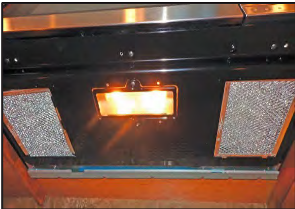
Figure 5-4: Air Filtration Fan
