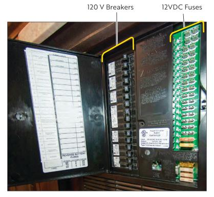
Figure 26. 120-Volt Circuit Breakers
