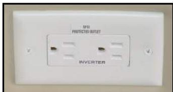
Figure 7-11. GFCI Receptacle
