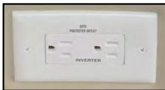
**Figure 7-11. GFCI Receptacle**
