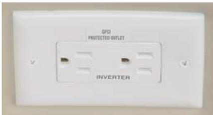
Figure 7-7. GFCI Receptacle
