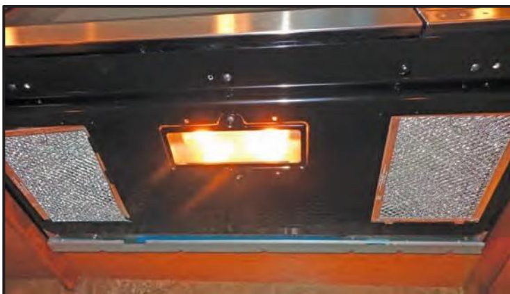
Figure 5-4: Air Filtration Fan
